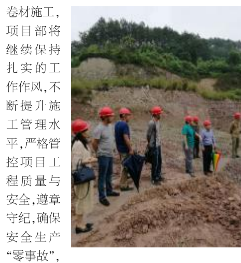
卷材施工,项目部将继续保持扎实的工作作风,不断提升施工管理水平,严格管控项目工程质量与安全,遵守守纪,确保安全生产“零事故”,做政府和人民满意的工程,为武义县的美丽蝶变贡献自己的一份力量。
